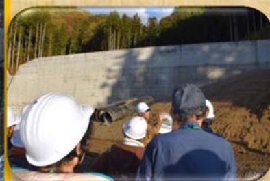
↑下洞沢砂防堰堤(新設)
