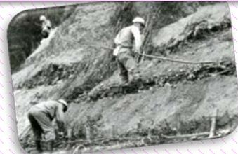
虎溪山山腹工は昭和27年に「等高線壕工法」で施工され、国内では3事例しかない日本の砂防史上において希少な工法を見学していただきました。現地では「等高線壕工法」の当時の形跡を見ていただきました。
