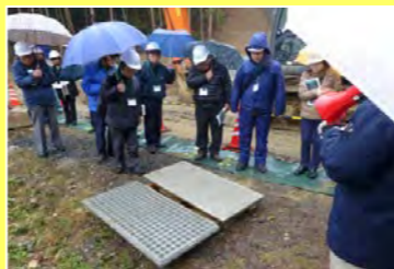
堰堤表面に使う景観に配慮した型枠とコンクリートの充填を確認する為の穴が開いた型枠
