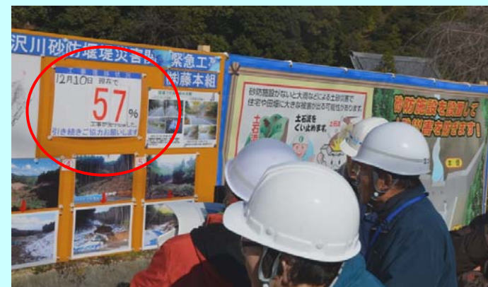
(工事進捗率の現場表示「見える化」)
