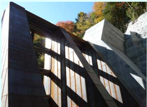
(堰堤の鋼製枠部)
