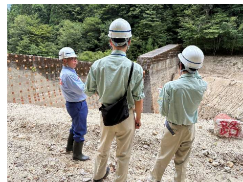
地獄谷第4砂防堰堤(除石工事)
