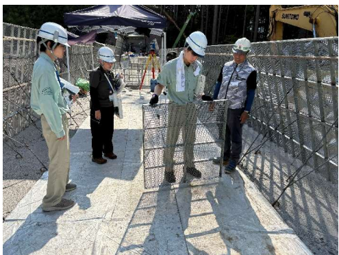
深沢砂防堰堤(コンクリート打設)
