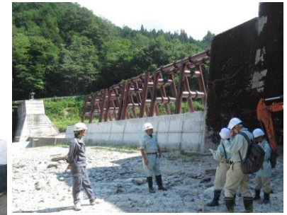
浦川第2砂防堰堤
