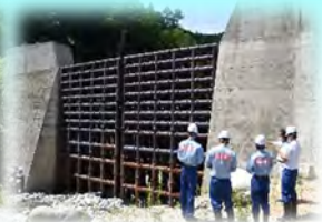
越百川第3砂防堰堤
