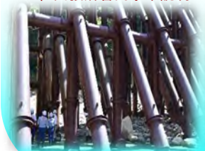
越百川第3砂防堰堤
