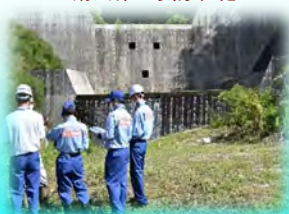
梨子沢第3砂防堰堤
