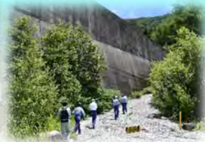
滑川第1砂防堰堤
