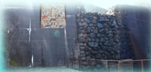
深山第1砂防堰堤
