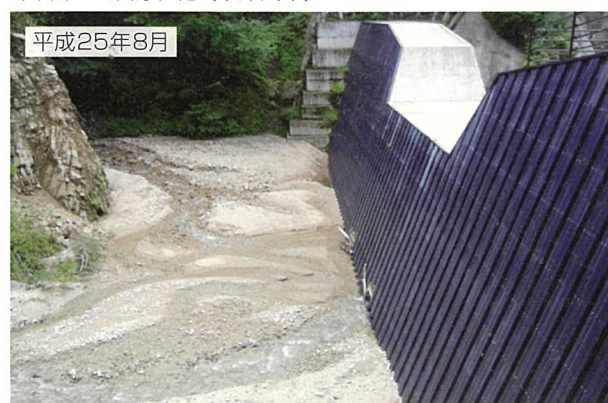
本谷第10砂防堰堤 (中津川市)
