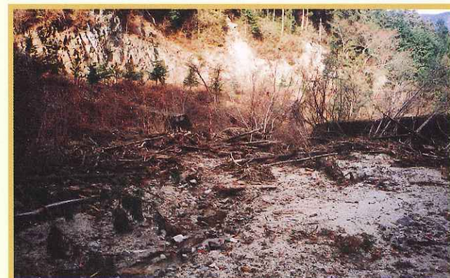
弥太洞第2砂防堰堤
