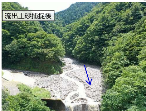
本谷第1砂防堰堤（中津川市）
