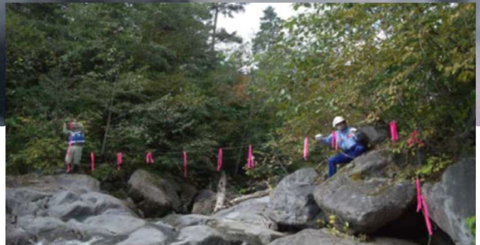
ワイヤーセンサーの設置状況
