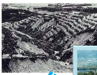
昭和20年代後半山腹工施工(昭和27～28年)
