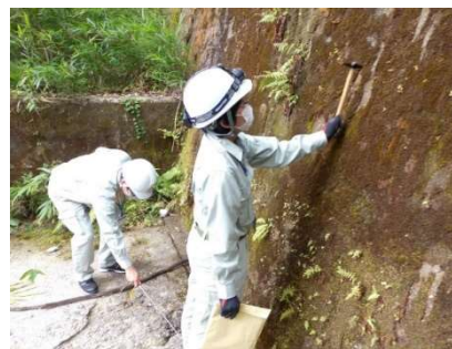
砂防施設の点検(打音検査) (土岐市:岩山第7砂防堰堤)
