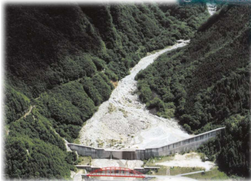
滑川第1砂防堰堤 [上松町]
