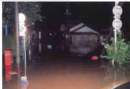
土岐市内の浸水状況
