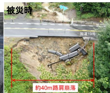
災害復旧工事(被災発生:R3.8.13、復旧工事完成:R4.12.28) (令和3年8月豪雨での国道19号中津川市落合における被災対応)
