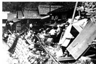
土石流に破壊された家屋
