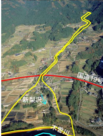
3.新梨沢砂防堰堤（中津川市）
