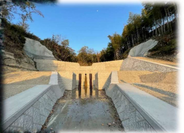
一の洞第2砂防堰堤 [土岐市]
