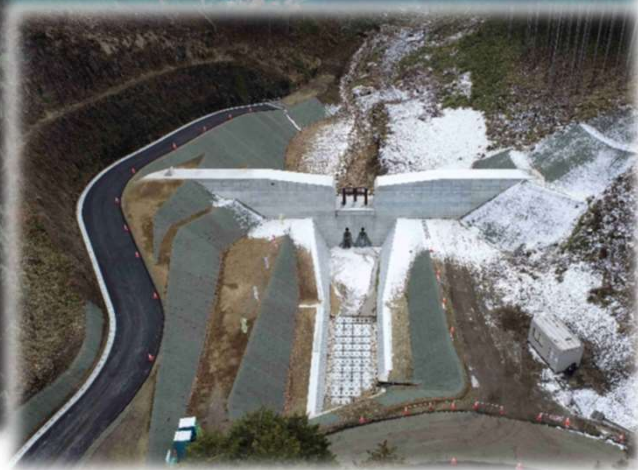
下在砂防堰堤工群 (宮ノ沢砂防堰堤) [大桑村]
