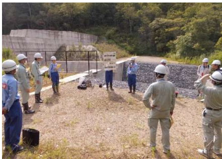
砂防施設点検の説明
