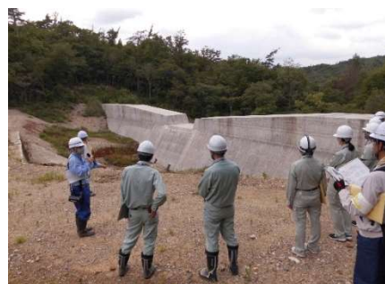
砂防施設の点検 (土岐市:岩山第4砂防堰堤)
