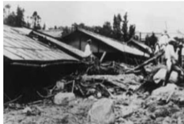
中津川市内の被災状況
