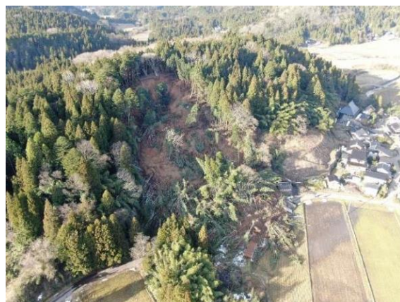
UAVによる被害状況調査
