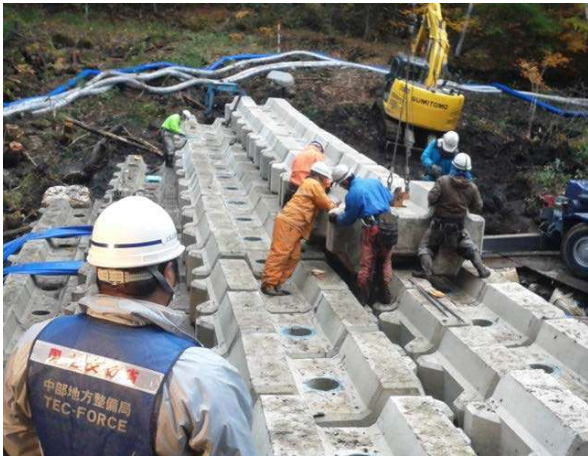
ブロック積み砂防堰堤設置の状況
