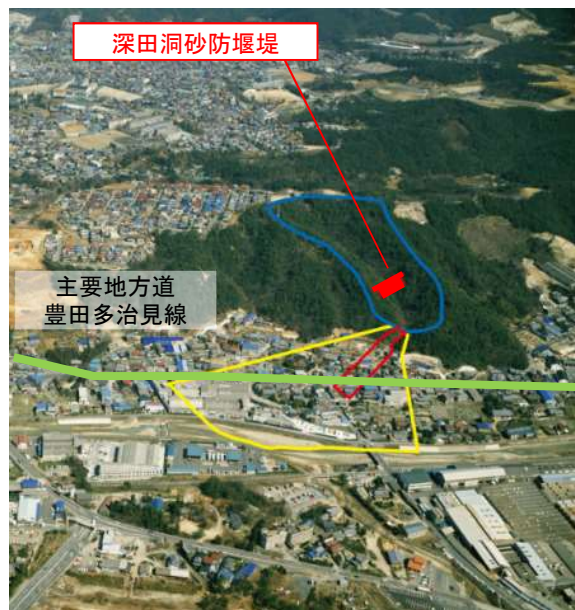
4. 深田洞砂防堰堤(多治見市)
