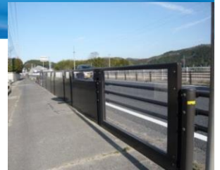
●騒音対策(低層遮音壁)の実施状況(瑞浪市釜戸町)
