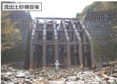
地獄谷第4砂防堰堤（中津川市）
