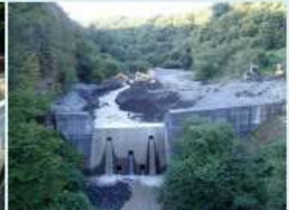
砂防堰堤の除石 (湯川、長野県)
