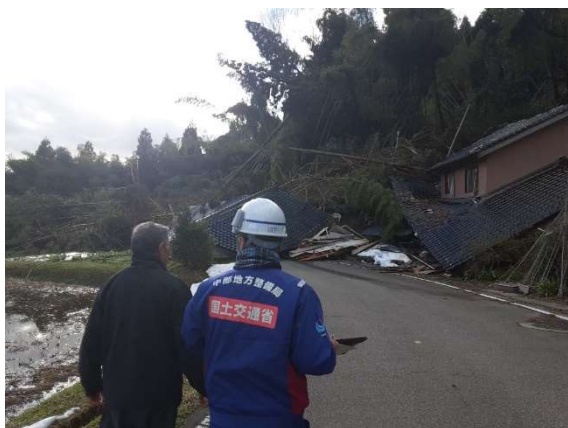
地元の方への被害状況聞き取り
