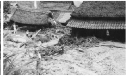
土砂流出により埋まった家屋
