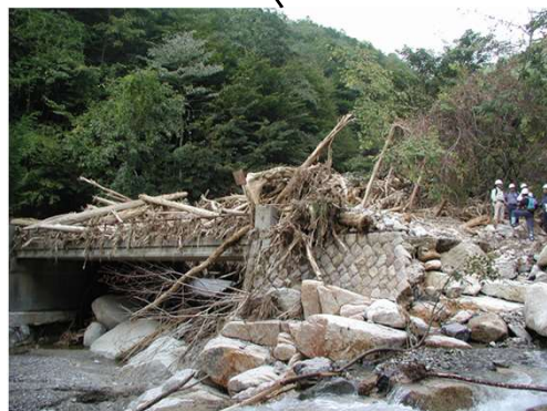
平成12年9月の恵南豪雨時の 流木による被災状況（中津川支川一ノ沢）
