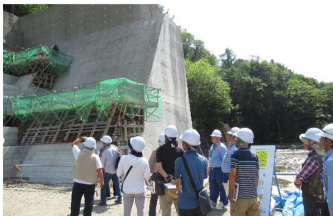
砂防堰堤見学(上松町:十王沢第2砂防堰堤)
