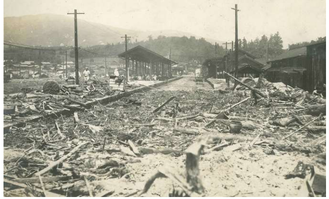
四ツ目川災害(中津川駅構内)
