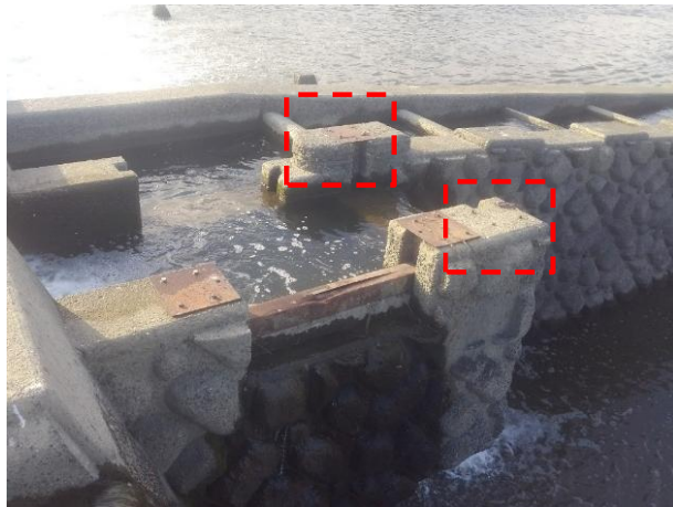
小田井床止の魚道角落プレートの修繕 (庄内川右岸17.6kp付近)
