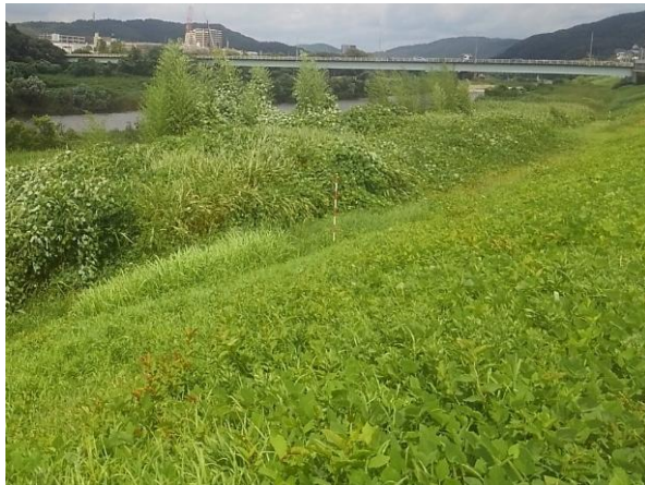
対策工実施前 (庄内川左岸34.8kp付近)
