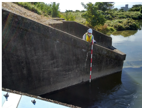
堤防（河川管理施設）点検
