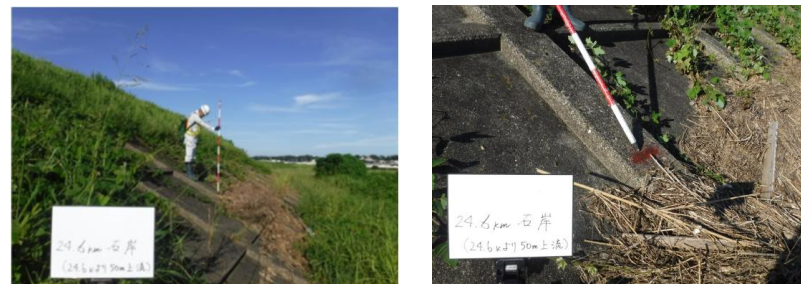
洪水痕跡調査の状況（右岸24.6km+50）
