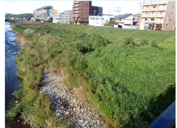
対策工実施前 (土岐川右岸57.4kp付近)
