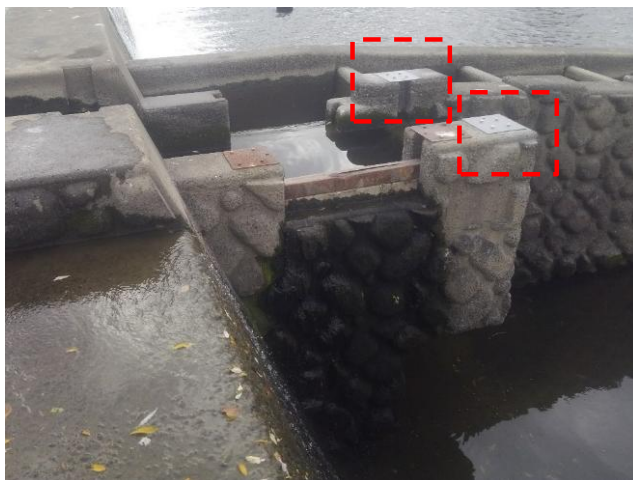
小田井床止の魚道角落プレートの修繕 (庄内川右岸17.6kp付近)
