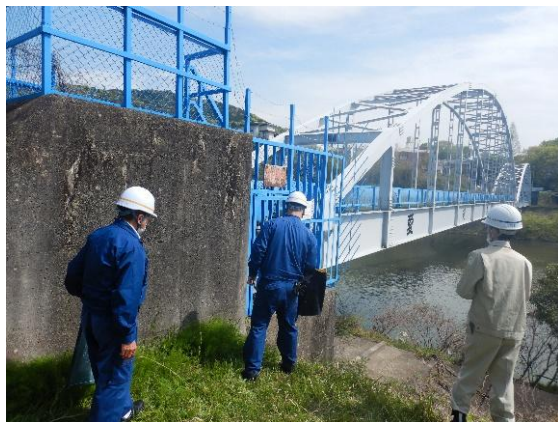
許可工作物（中村ポンプ場）点検
