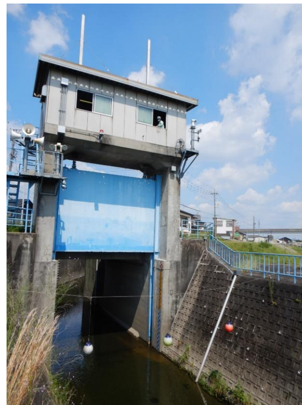
守山排水樋門
