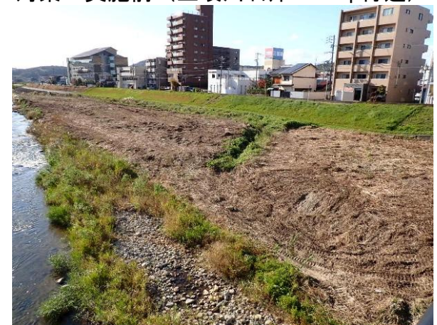
対策工実施後 (土岐川右岸57.4kp付近)
