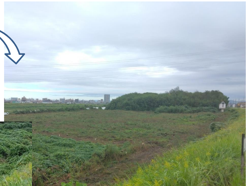
対策工実施後（庄内川左岸28kp付近）
