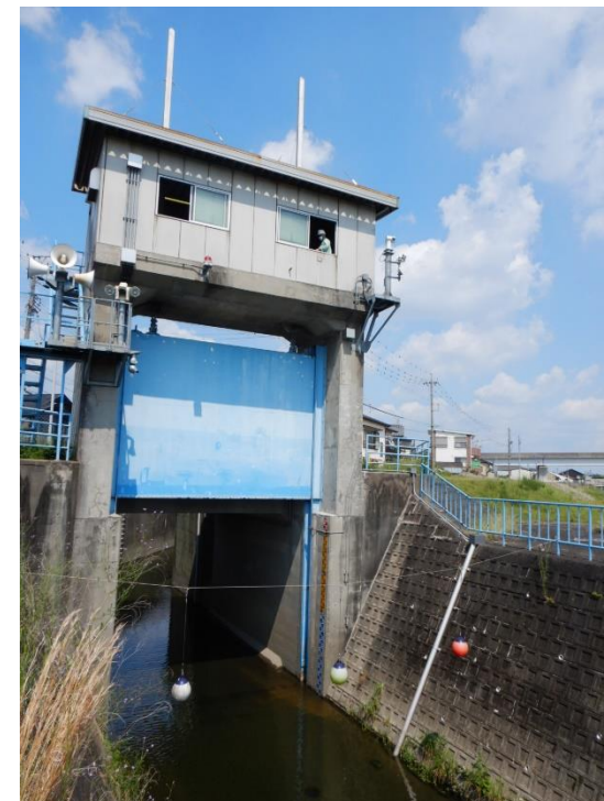
守山排水樋門
