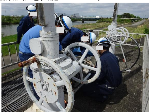
許可工作物（中村ポンプ場）点検
