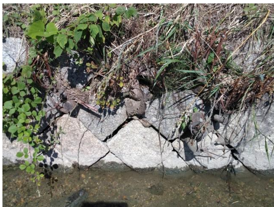
堤脚に侵入した樹木を伐採・堤脚補修 (庄内川左岸22.4kp付近)
