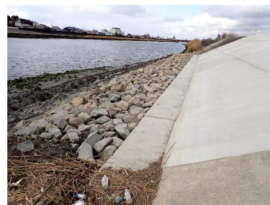
老朽化による護岸の損傷を補修 (庄内川左岸2.8kp付近)
