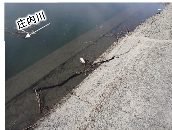
老朽化による護岸の損傷を補修 (庄内川左岸2.8kp付近)
