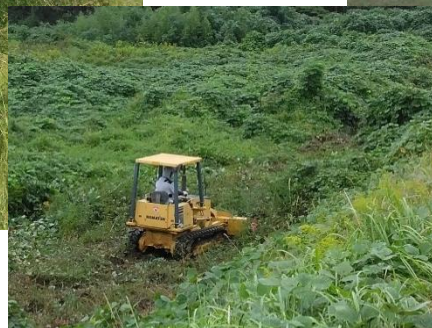
ブルドーザにて踏み倒し
