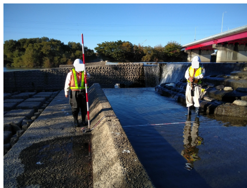
堤防（河川管理施設）点検
