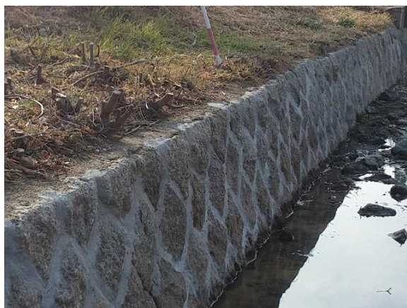
堤脚に侵入した樹木を伐採・堤脚補修 (庄内川左岸22.4kp付近)
