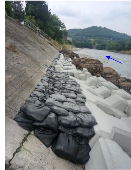
被災状況(左)及び耐候性土のう袋(コンクリート詰)設置状況(右)
