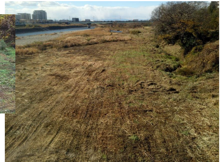
対策工実施後（庄内川右岸35kp付近）
