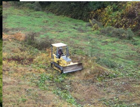
ブルドーザにて踏み倒し
