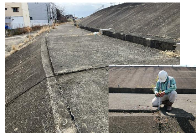
老朽化による護岸の損傷を補修 (庄内川左岸2.8kp付近)
