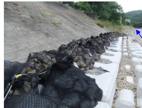
耐候性土のう袋(コンクリート詰)の上に袋詰め玉石設置状況
