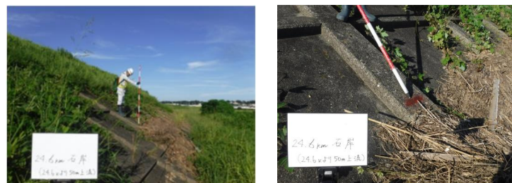
洪水痕跡調査の状況（右岸24.6km+50）
