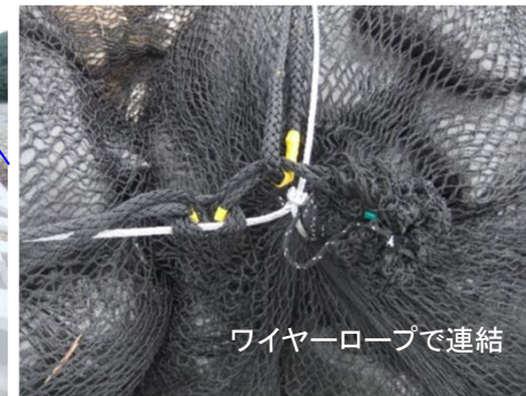
耐候性土のう袋(コンクリート詰)の上に袋詰め玉石設置状況
