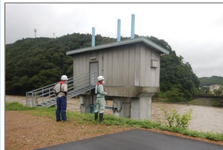
出水時巡視施設状況確認
