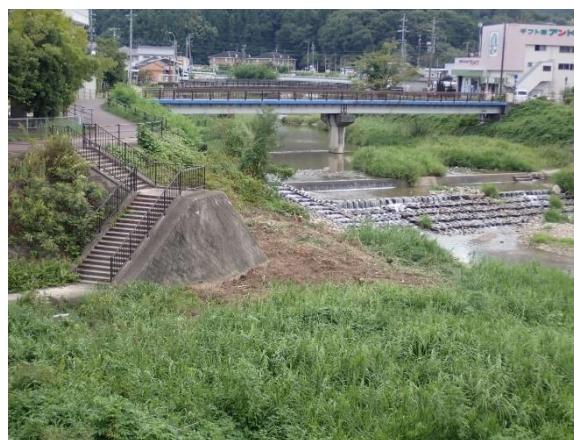
護岸付近に繁茂した樹木を伐採 (土岐川左岸48.4kp付近)
