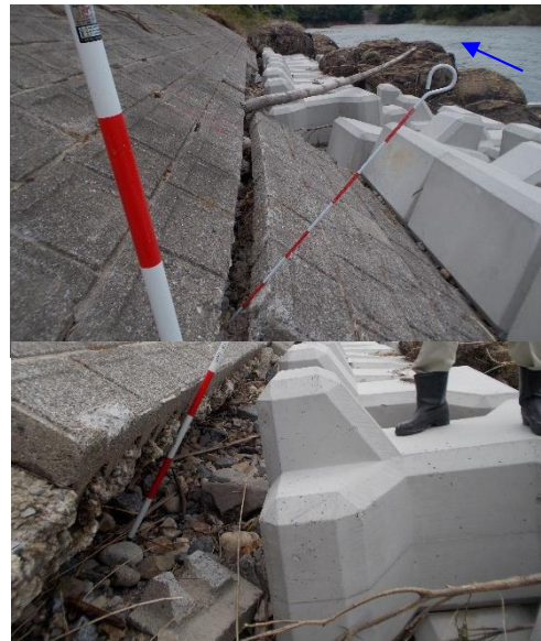
被災状況(左)及び耐候性土のう袋(コンクリート詰)設置状況(右)
