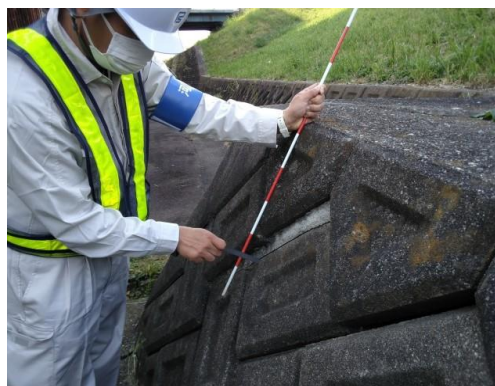
堤防（河川管理施設）点検
