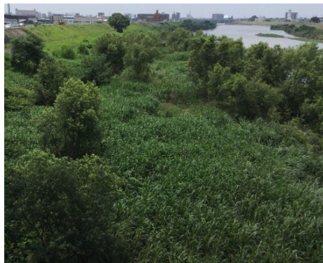
枇杷島水位観測所 (河道掘削状況)
