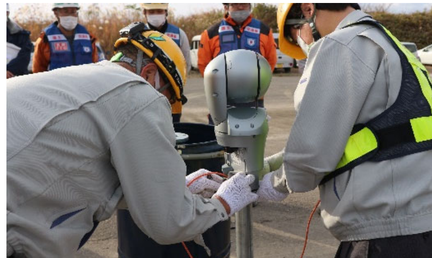
漏水監視カメラの組み立て方操作訓練状況
