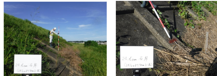
洪水痕跡調査の状況（右岸24.6km+50）
