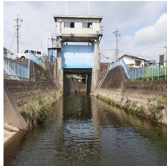
守山排水樋門
