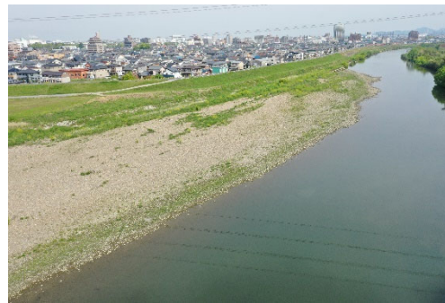
上条地区 (河道掘削状況)
