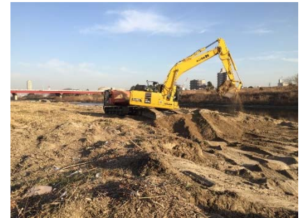
維持修繕工事
