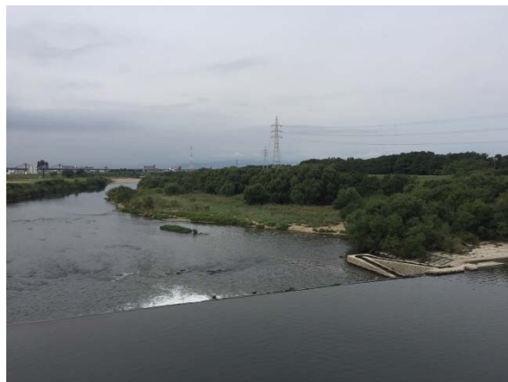
掘削・伐開前
