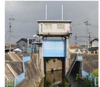
守山排水樋門
