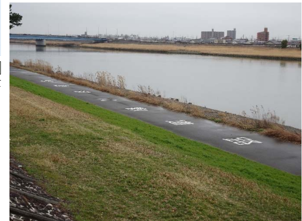
緊急河川敷道路
