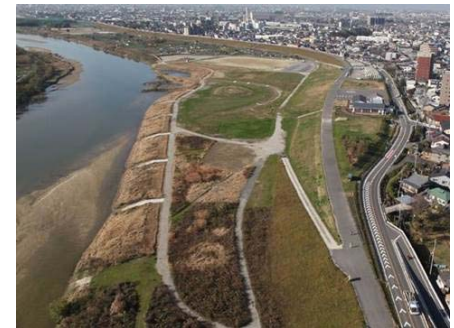
西枇杷島地区水辺整備
