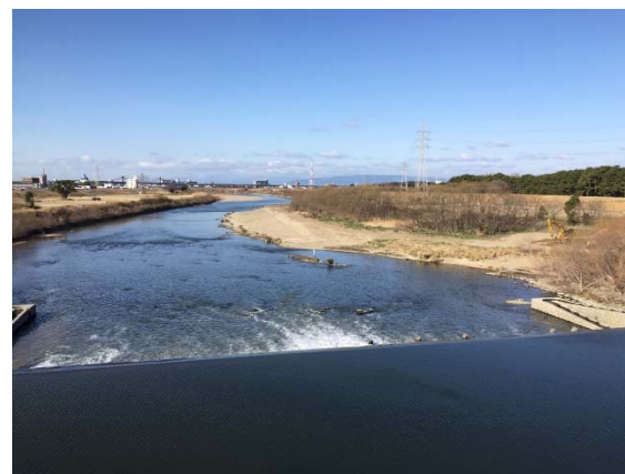
掘削・伐開後
