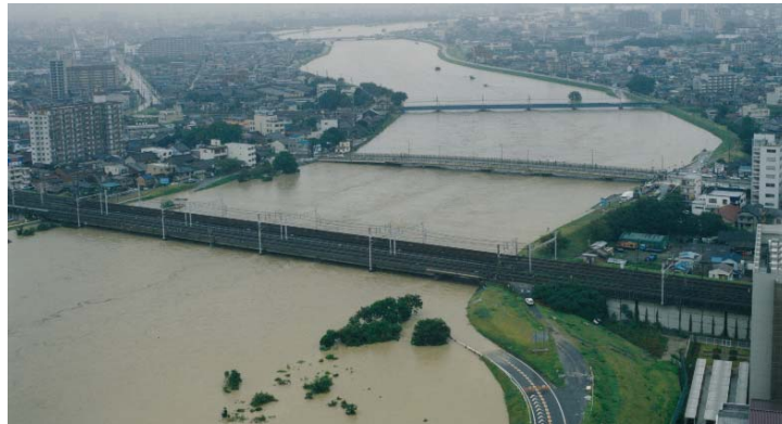
新幹線橋梁付近の状況 (H12.9月洪水(東海豪雨))
