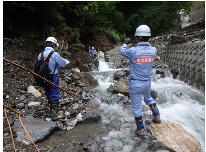
砂防堰堤の被害状況調査（7/21）
