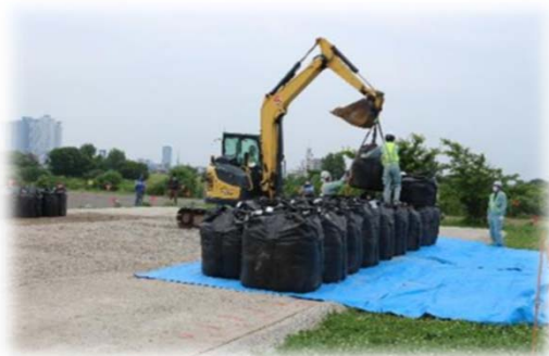
枇杷島地区の水防活動（土のう積み）を想定し訓練を実施！
