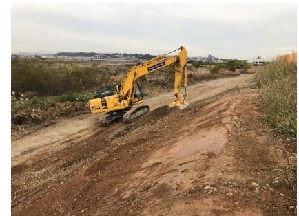
維持修繕工事
