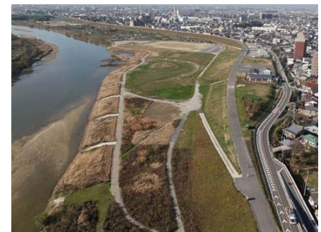
西枇杷島地区水辺整備
