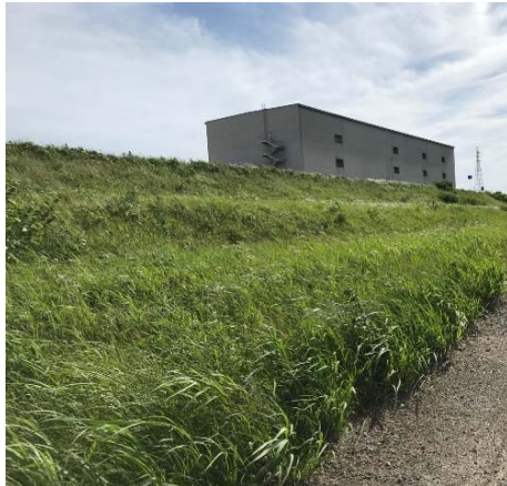
堤防法面の不陸 （庄内川 24.2k付近）
