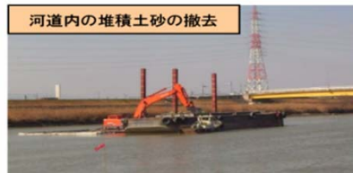
河道内の堆積土砂の撤去 洪水等により河道に堆積した土砂を掘削し撤去する
