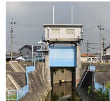
守山排水樋門
