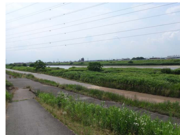
緊急河川敷道路
