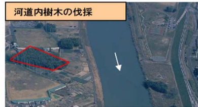
河道内樹木の伐採 流下障害となる河道内の樹木の伐採を行う
