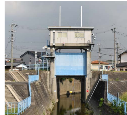
守山排水樋門
