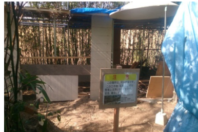
警告看板による不法工作物撤去指導
