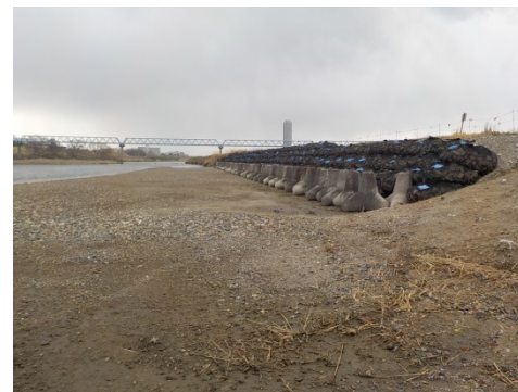
根固めブロック及び袋詰め玉石の設置
