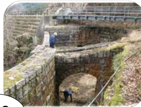
旧発電所水路周辺の整備
