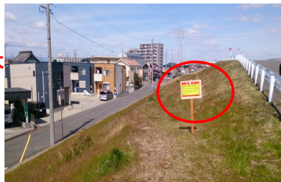
堤防部の車両走行をやめてもらう看板設置例
