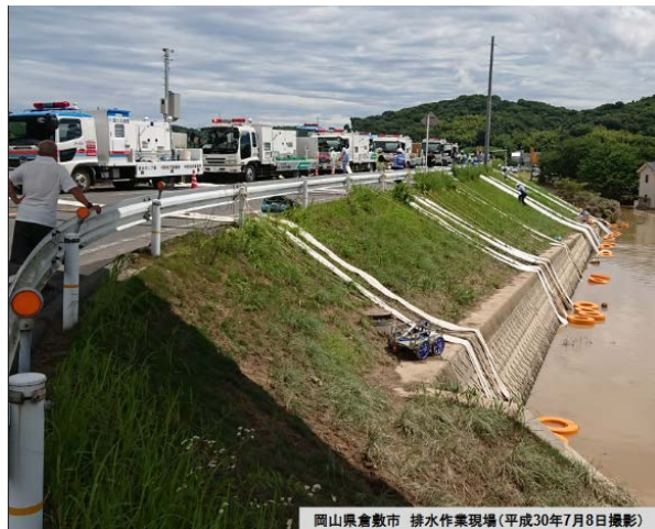
倉敷市における排水作業
