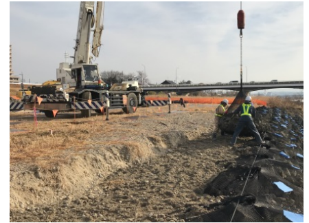
維持修繕工事
