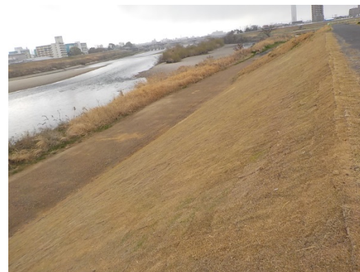
堤防法面の修繕
