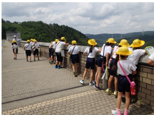
ダムの天端から下流を臨む
