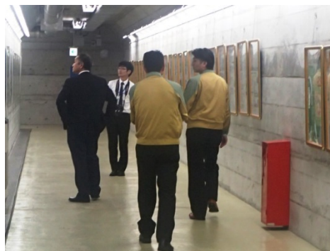
ダム堤体内部の視察
