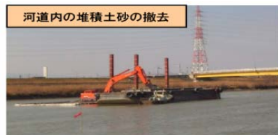
河道内の堆積土砂の撤去
