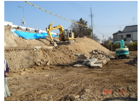
維持修繕工事
