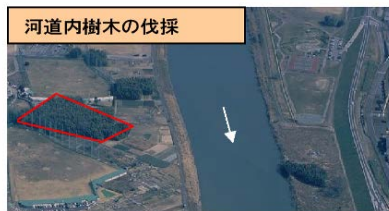
河道内樹木の伐採
