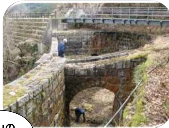
旧発電所水路周辺の整備
