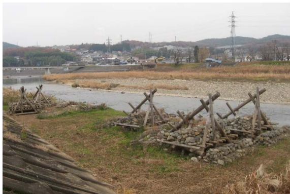
聖牛の損傷 (土岐川 56.2k付近)
