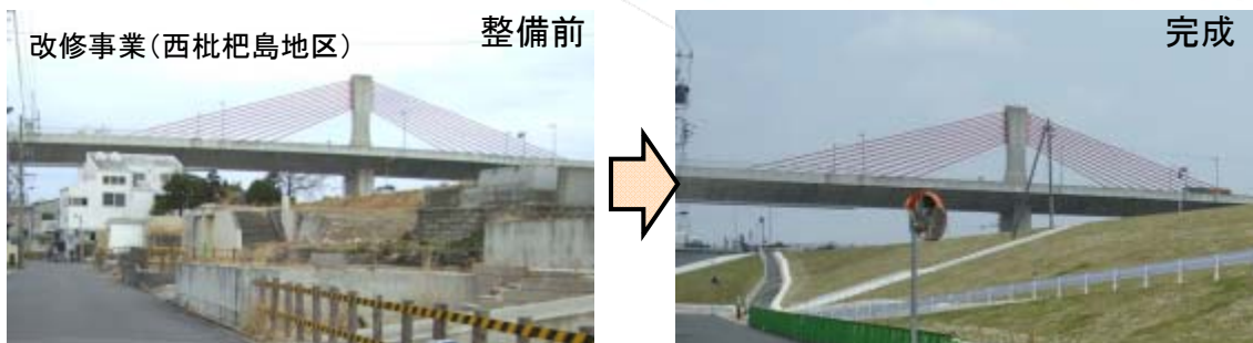
平成23年度 庄内川西枇杷島築堤護岸工事(平成25年3月完成、堤防を嵩上げ)
