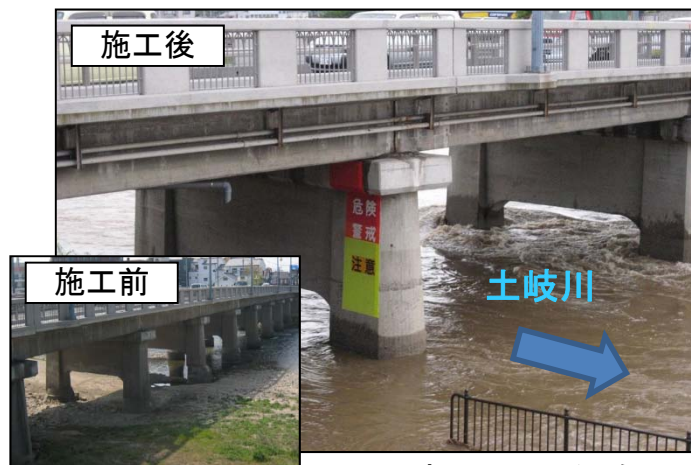
■ 表示を行った橋梁 堤防から見えるように表示した多治見橋の水位 監視カメラで拡大表示した志段味橋の水位(ホームページ画面)
