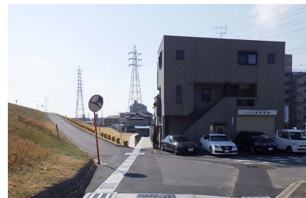
堤脚水路の補修
