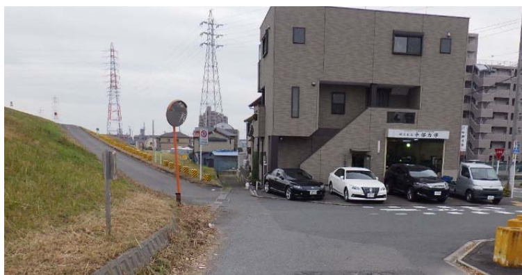
堤脚水路の排水不良 (庄内川 7.4k 付近)
