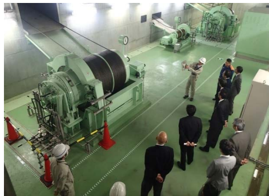
ダム内部のゲート設備を見学
