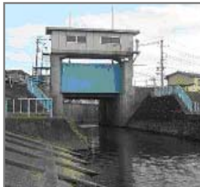
守山排水樋門
