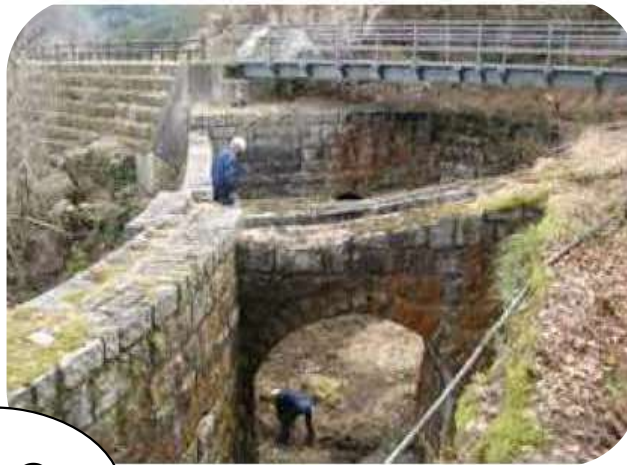
旧発電所水路周辺の整備
