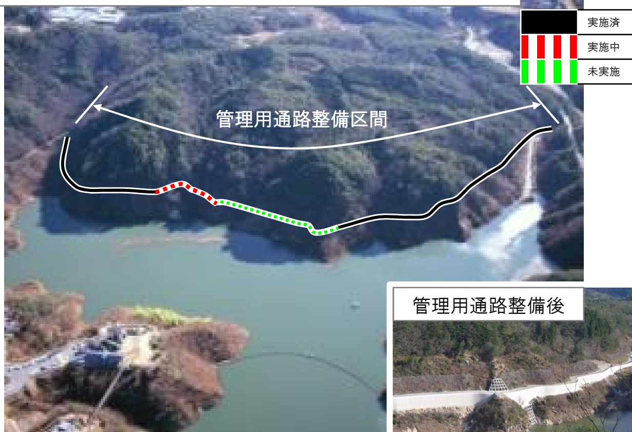
管理用通路整備（貯水池の裏面の崩壊対策）
