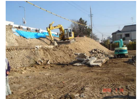
維持修繕工事
