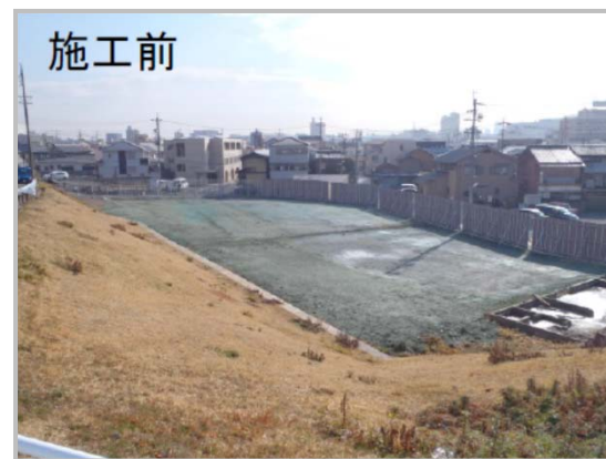
平成27年度工事実施箇所状況
