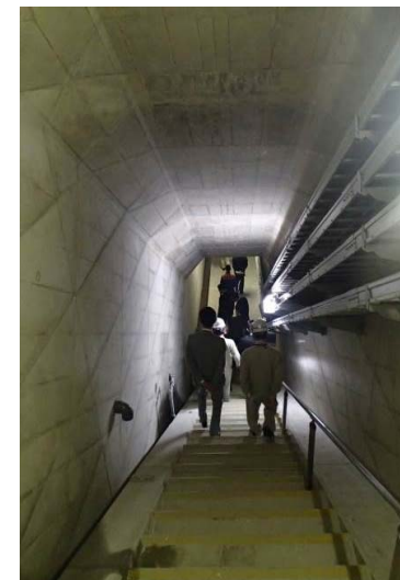
とても深いダムの監査廊
