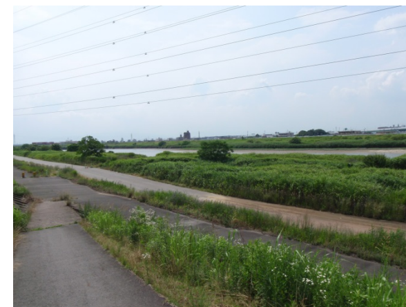
緊急河川敷道路
