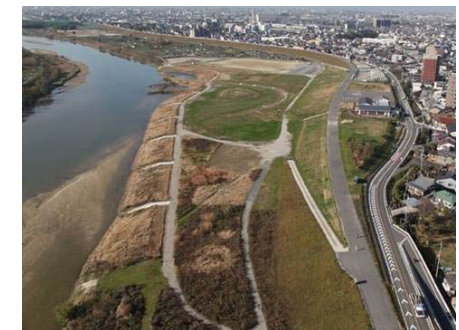
西枇杷島地区水辺整備
