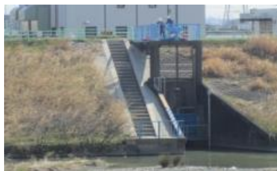
御幸排水樋門(現況)
