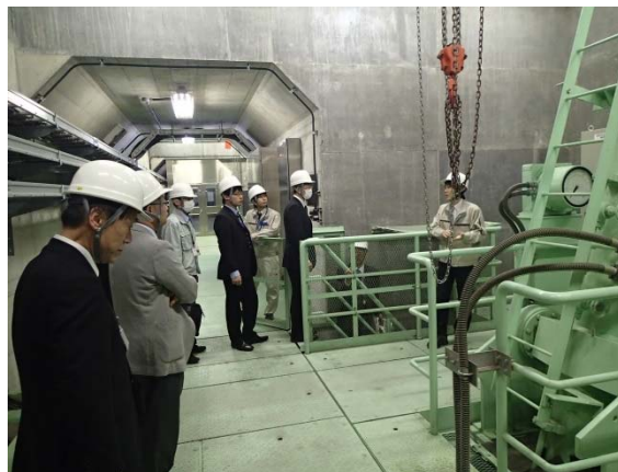
ダム内部のゲート室を見学
