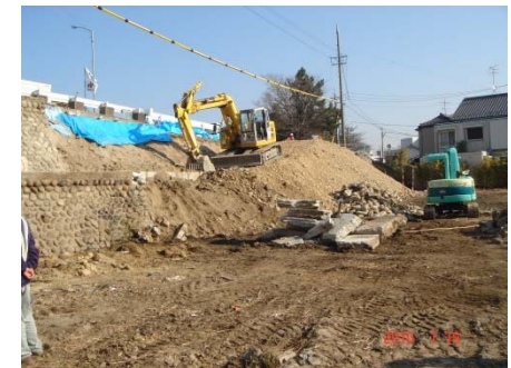
維持修繕工事
