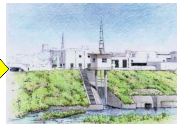
御幸排水樋門の上屋及び電動化 (完成予想図)
