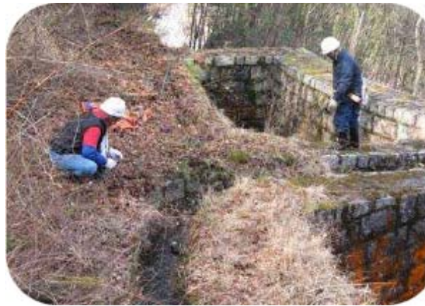
旧発電所水路周辺の整備
