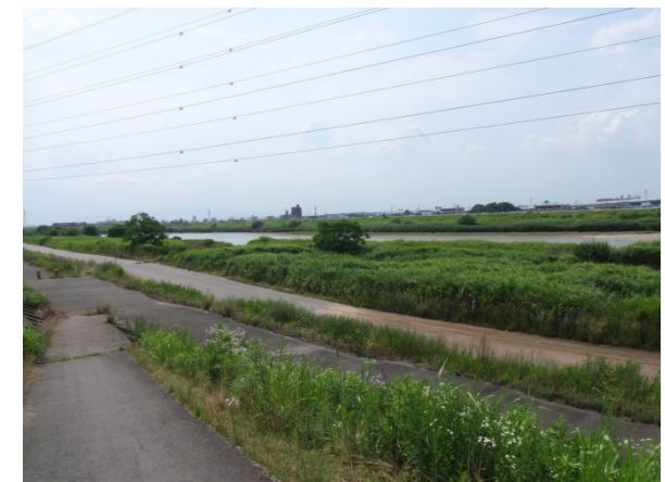
緊急河川敷道路
