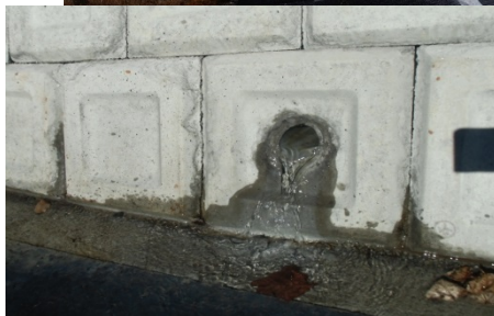
水抜きパイプからの排水状況
