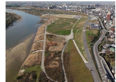
西枇杷島地区水辺整備
