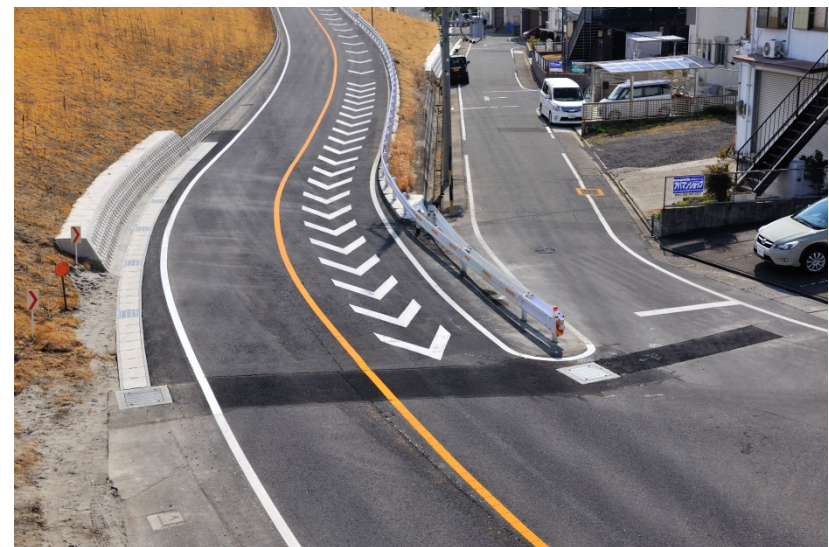
堤脚水路を整備
