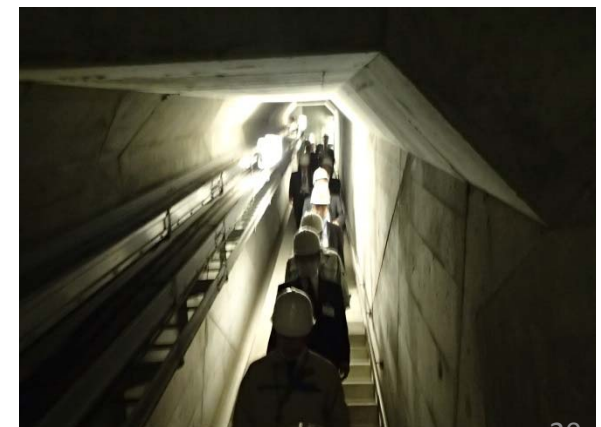
ダムの監査廊を歩く
