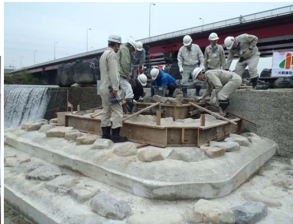
庄内川にアユをもっと戻すため、河川協力団体との共同で小田井床止に棚田式魚道を設置(平成26年4月22日の状況)
