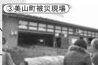
③美山町被災現場
