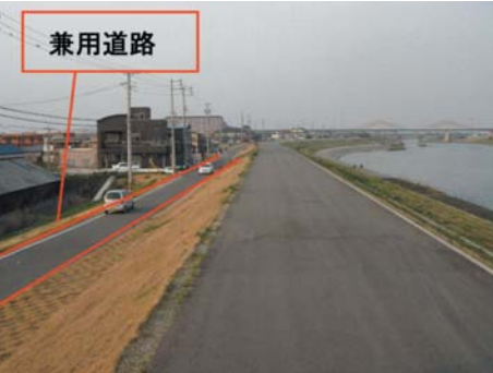
●写真4.3.3 管理用道路と分離し道路を小段に設置した事例
