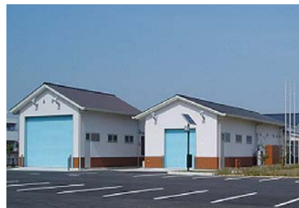
清須市庄内川水防センター（14.0k右岸付近）
