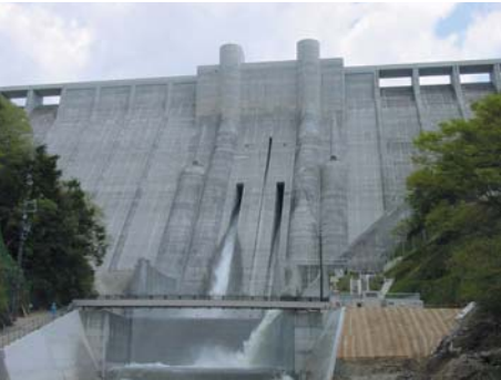
●写真4.3.1 小里川ダムの管理
