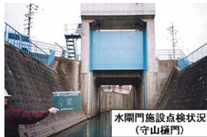
施設管理（水閘門等施設の点検・修繕）
