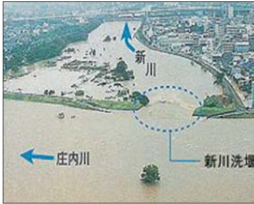
（新川先堰（河口から約19.3k）付近）
