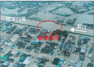
●写真2.1.3 新川の破堤地点の被災状況 (名古屋市区)
