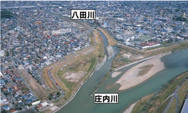
●写真4.2.1 排水の影響が見られる庄内川の八田川合流部
