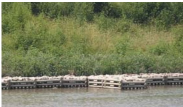
●写真4.3.4 庄内川の護岸整備例
