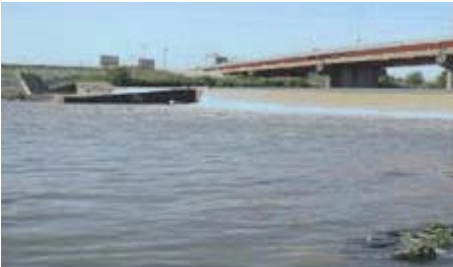
●写真2.1.17 小田井床止め
