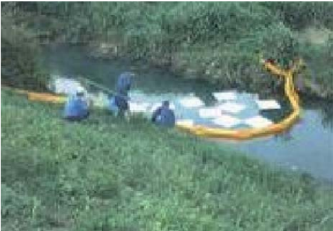
●写真2.1.26 水質事故対策 （オイルフェンス、オイルマット）
