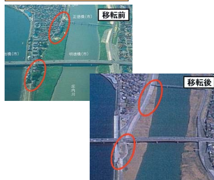
占用家屋移転の例（明徳橋右岸）
