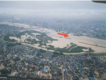
洪水時（撮影：平成12年9月洪水）
