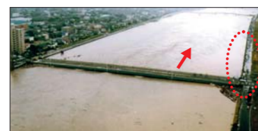
●写真2.1.1 一色大橋右岸の越水状況 (名古屋市中区)
