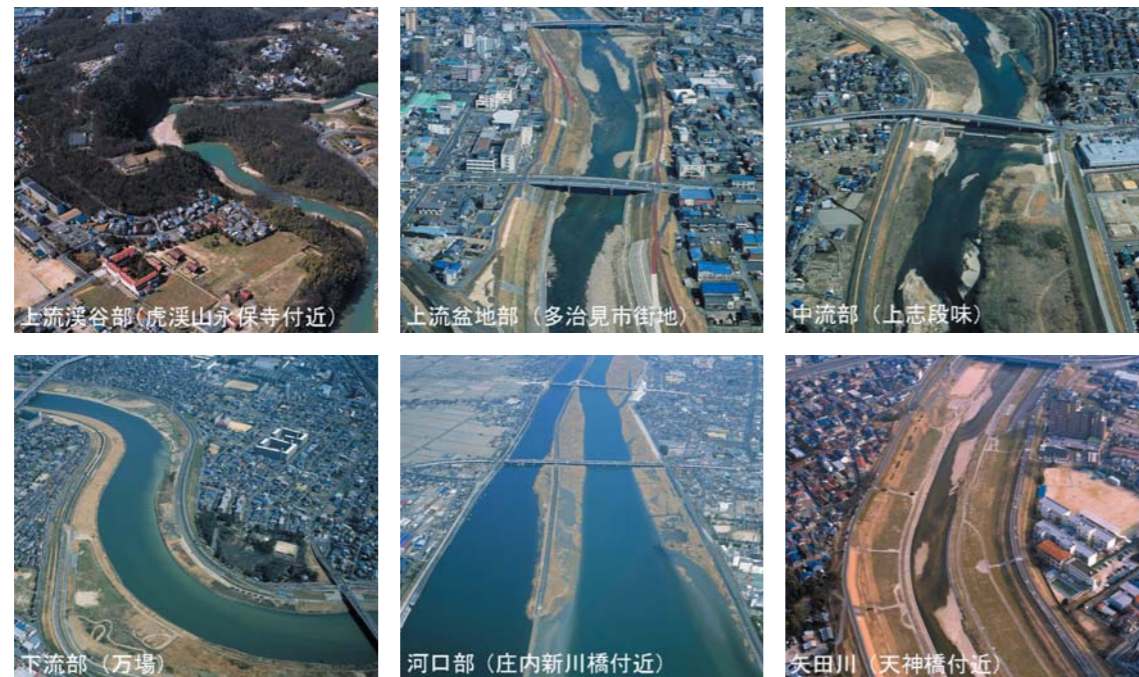
●写真2.1.10 庄内川及び矢田川の状況
