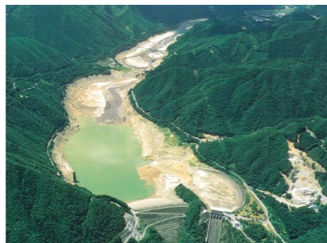
●写真2.1.8 平成6年牧尾ダム(木曾川水系)の枯渇状況
