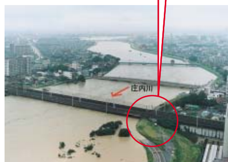
●洪水時の枇杷島地区の様子(平成12年東海豪雨)
