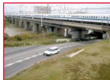
●平常時の堤外アンダーパスの様子
