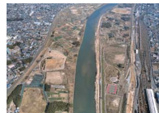
●高水敷利用(13.0k付近)の様子
