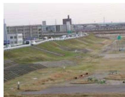
●アクセス困難な河川敷の様子
