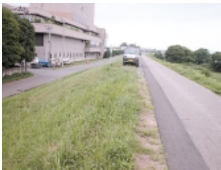
堤防側帯(北上川):堤防側帯は水防活動等のために盛土して堤防の上幅を広げる方法 *堤防側帯の方法を応用したミニ水防拠点充実していくことは可能と思われる。
