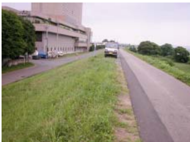
堤防側帯（北上川）：堤防側帯は水防活動等のために盛土して堤防の上幅を広げる方法
