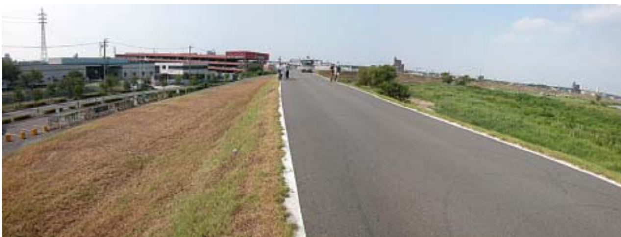
万場大橋下流右岸蛇行部（下流方向から）
