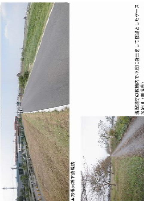
堤防天端の拡幅で小段に遊歩道を設置して保護としたケース
