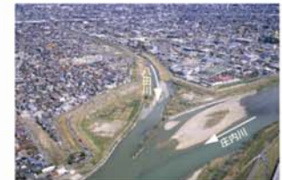
排水の影響が見られる八田川合流部
