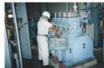
排水機場の点検
