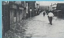
(土岐市内) 昭和47年7月 洪水の被害の様子
