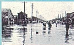
(名古屋市港区) 昭和34年9月 伊勢湾台風の被害の様子
