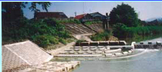
魚道の改善事例(高貝用水堰)
