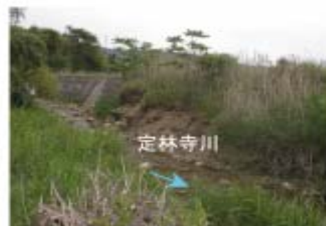
②定林寺川合流部の様子
