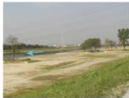
①高水敷壁下げの様子
