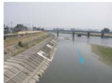
②水際の部の低水護岸の様子
