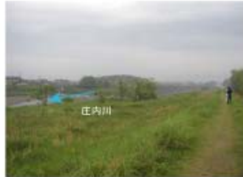
② 野添川合流部付近の小堤の様子
