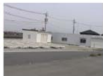
⑦水防拠点の水防倉庫の様子
