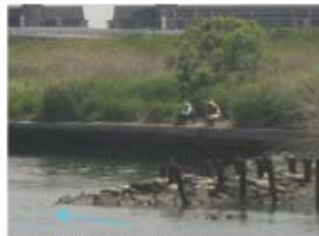
①水際の矢板護岸の様子
