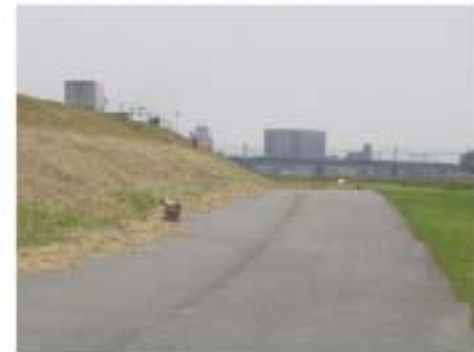
①緊急河川敷道路の様子
