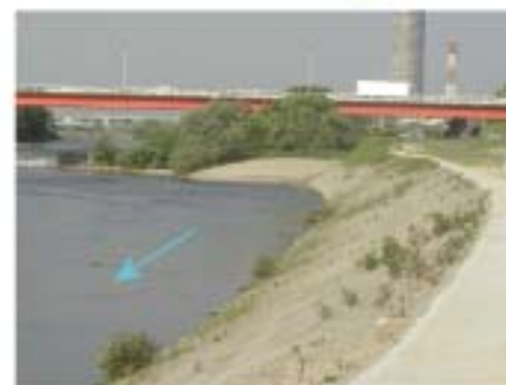
②水際の治水護岸の様子
