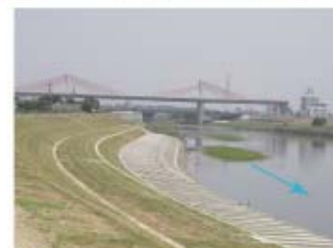
③水際の部の低水護岸の様子
