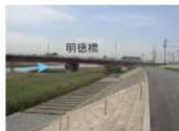
⑥水防拠点前面の階段護岸の様子
