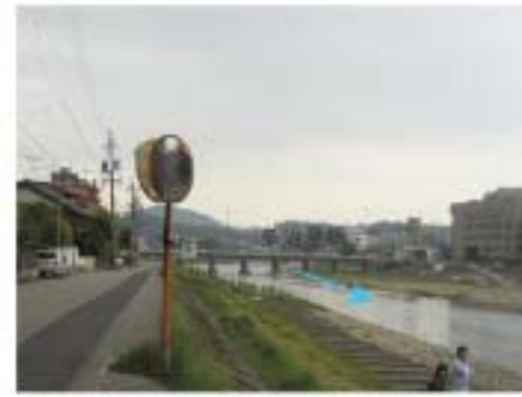
③昭和橋上流の右岸堤防道路の様子
