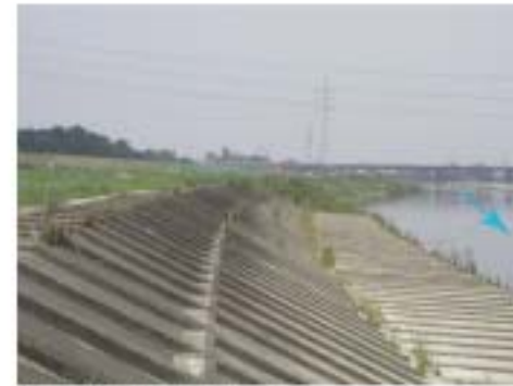
④水際の部の低水護岸の様子
