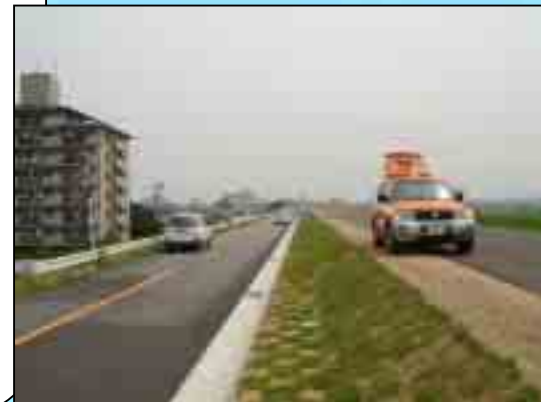
道路を小段に設置した事例
