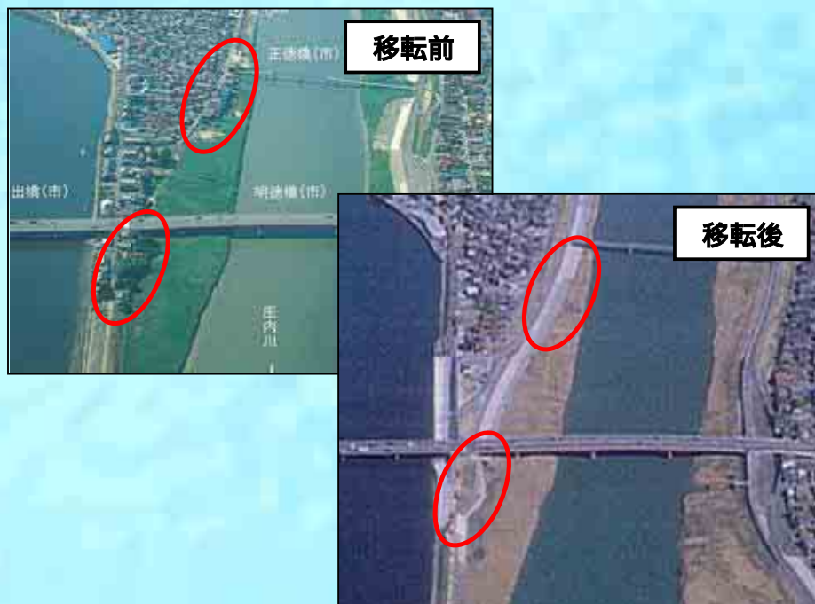
占用家屋移転の例(明徳橋右岸)
