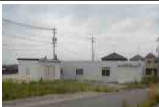
下之一色水防拠点 (3.4k右岸付近)
