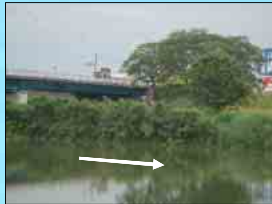
河道内樹木の繁茂状況
