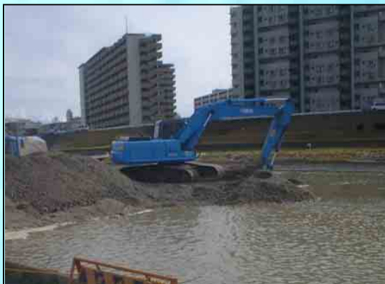
維持掘削状況
