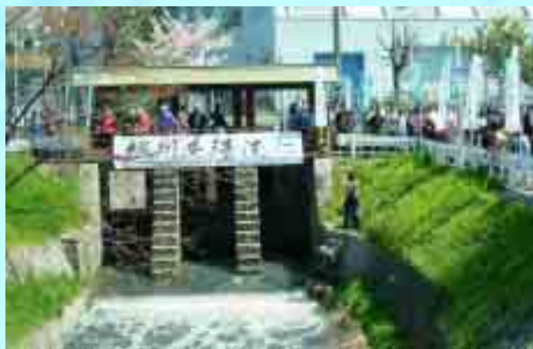
堀川試験通水の様子
