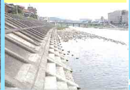
多治見市内の護岸の様子
