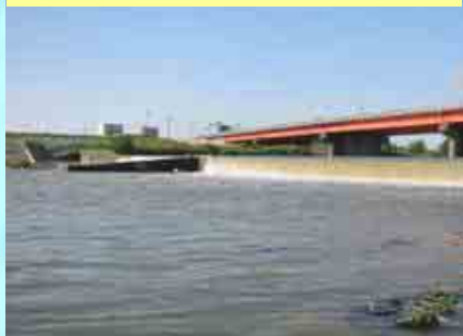
小田井床止めの様子 (17.4k付近)
