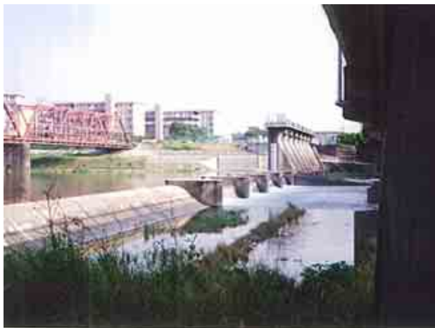
庄内用水頭首工
