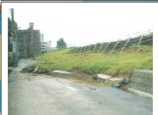
八田川0.9km付近左岸堤防崩壊
