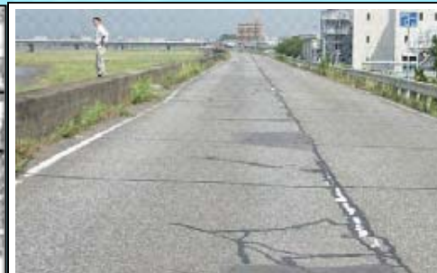
高潮堤防の堤防天端のヒビワレ状況 (0.8k左岸付近)
