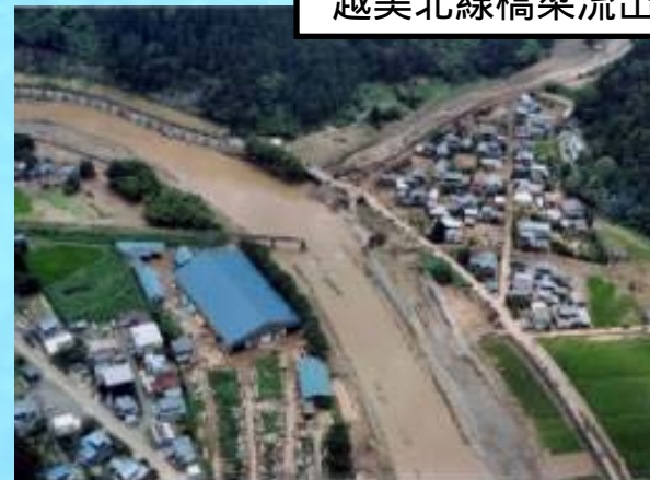
越美北線橋梁流出
