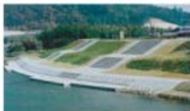
階段護岸の整備状況(徳幸川伏付近)
