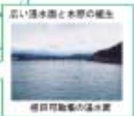
古い取水堰と水際の雑生 蓮湖調整池の取水堰
