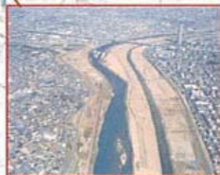
●新川洗堰付近(19.0 km付近):グラウンド(名古屋市)
