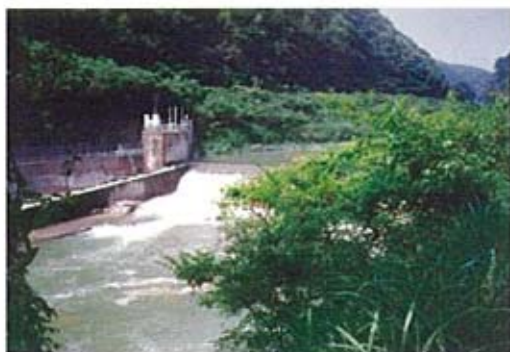
●玉野取水堰（40.6k付近）の様子
