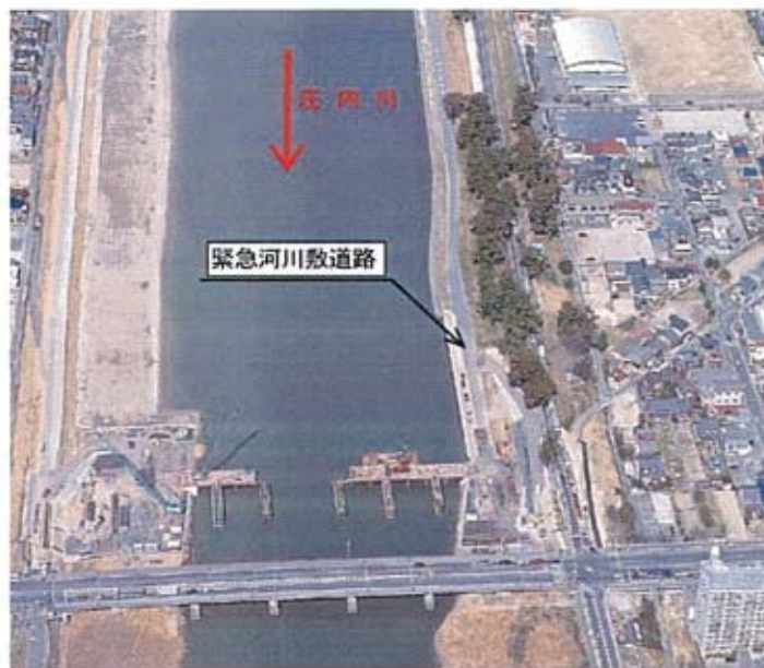
●緊急河川敷道路 (H15年3月撮影)
