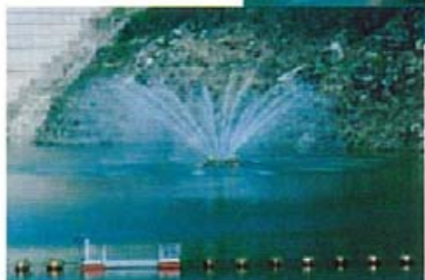
●小里川ダムにおける水質対策(表層循環設備)
