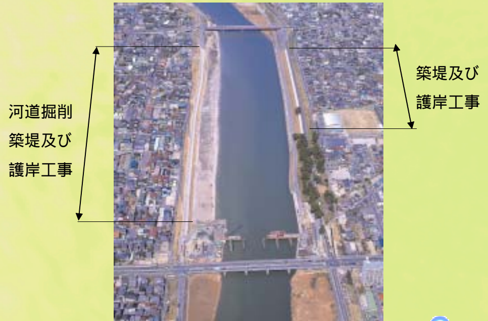
一色大橋～大当郎橋 事業進捗状況
