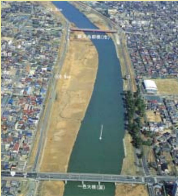
一色大橋～大当郎橋 事業前状況
