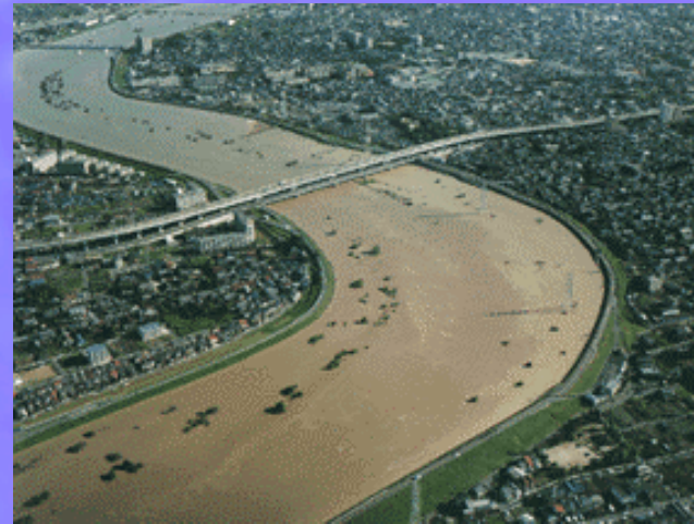
(万場大橋付近)
