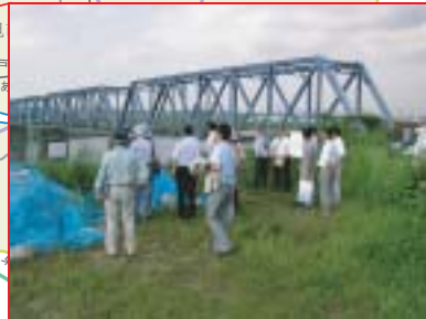
⑨庄内用水頭首工
