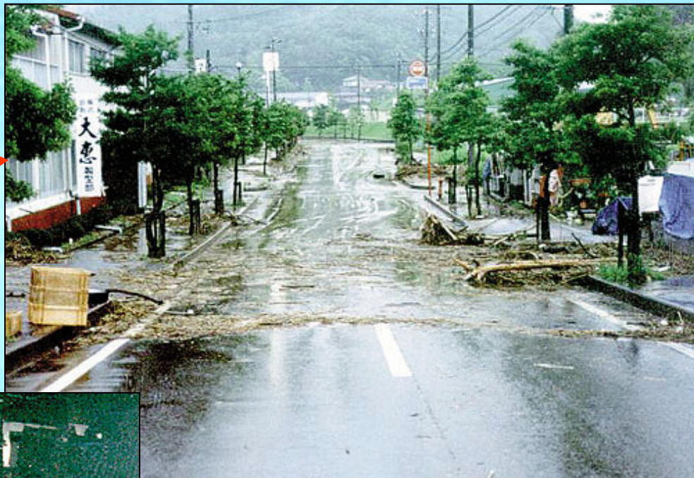
和合地先の浸水状況 県道421号線 (平成11年6月30日)
