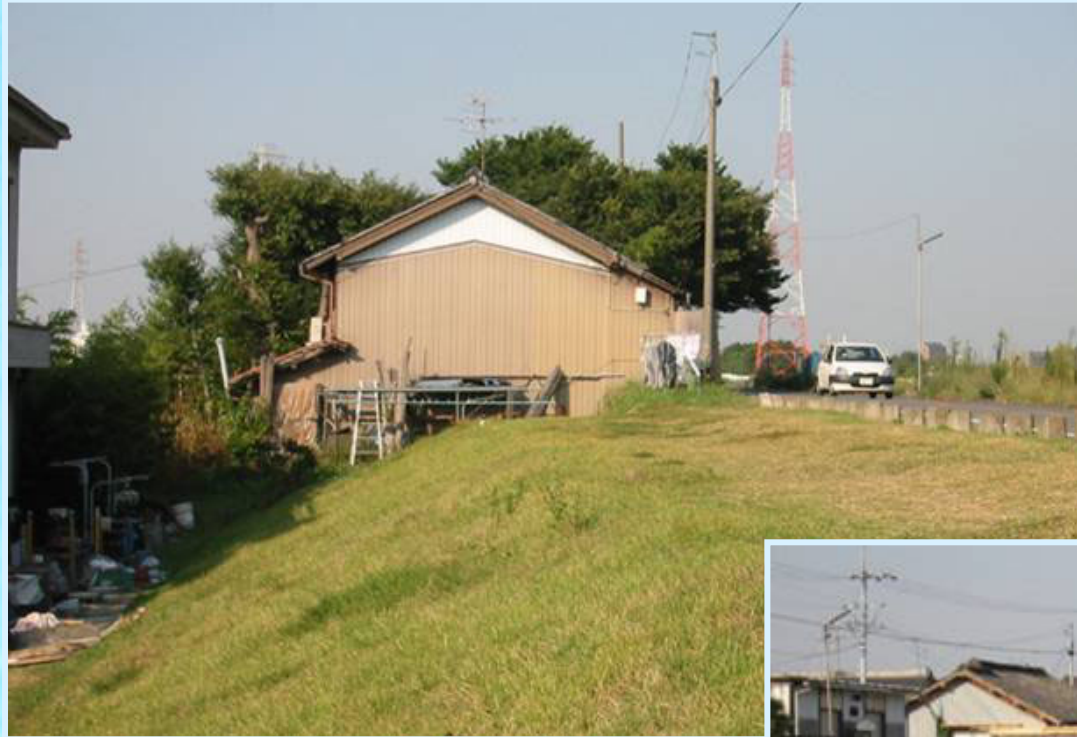
16k 右岸付近の状況
