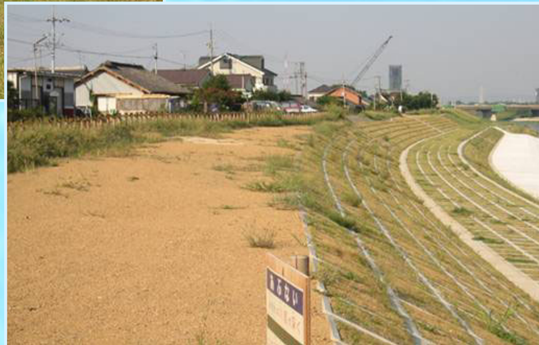
15k 右岸付近の状況
