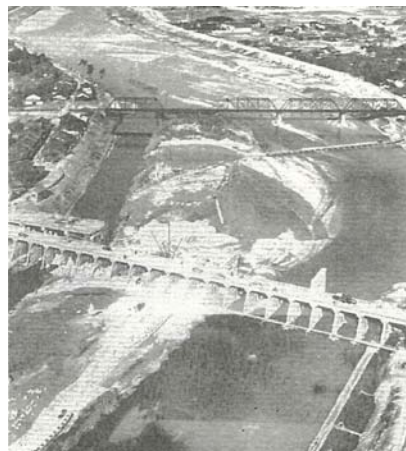
写真-4 中島の撤去工事
