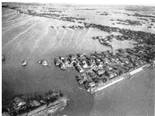
写真-6 新川右岸（港区南陽町七ツ島） 浸水状況
