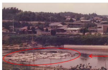
掘削前 撮影:昭和53年頃
