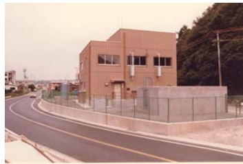
排水機場外観 撮影：S53
