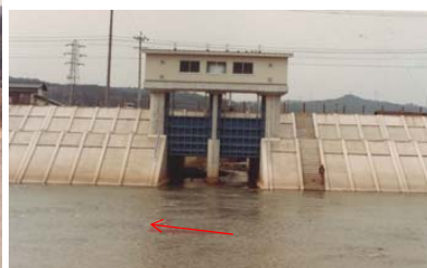
久尻排水樋管完成時 撮影:昭和57年9月
