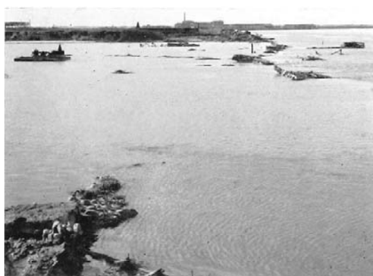
写真-7 庄内川左岸破堤状況
