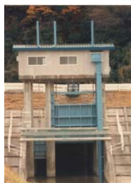
吐出し樋管 撮影：S62
