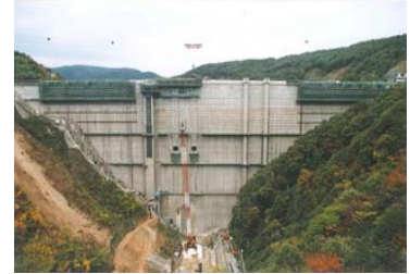
平成13年10月31日 打設完了
