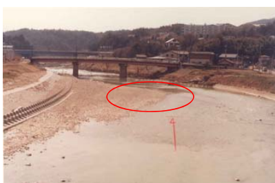
掘削後 撮影:昭和56年3月
