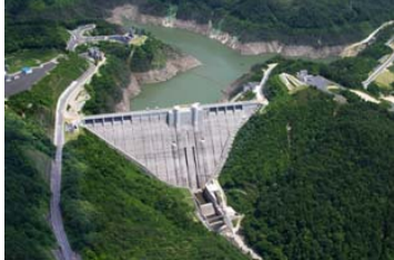
小里川ダム建設事業完成
