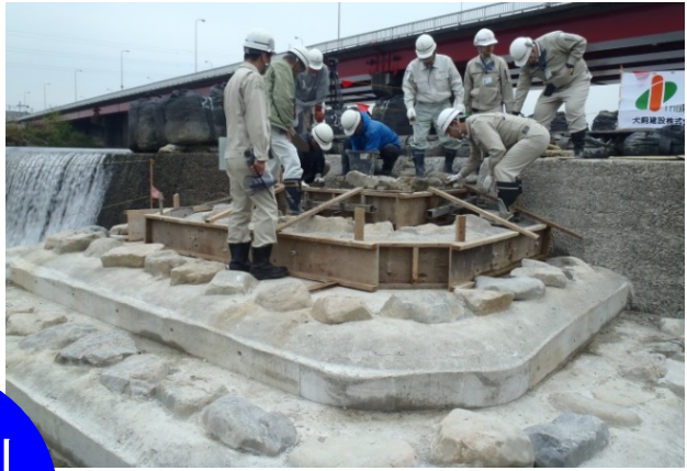
河川管理者と協働による魚道工事(矢田・庄内川をきれいにする会)
