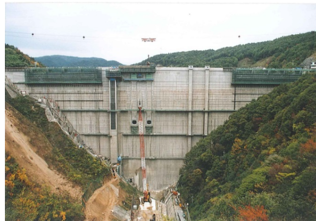
平成13年10月31日 打設完了
