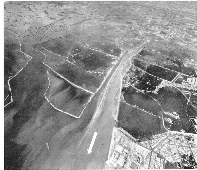
新川右岸(港区南陽町 セツ島) 浸水状況
