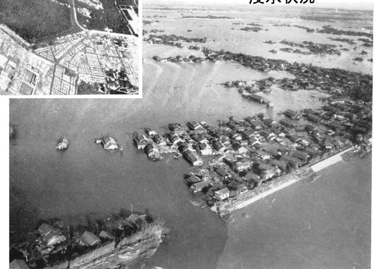
新川右岸(港区南陽町 セツ島) 浸水状況
