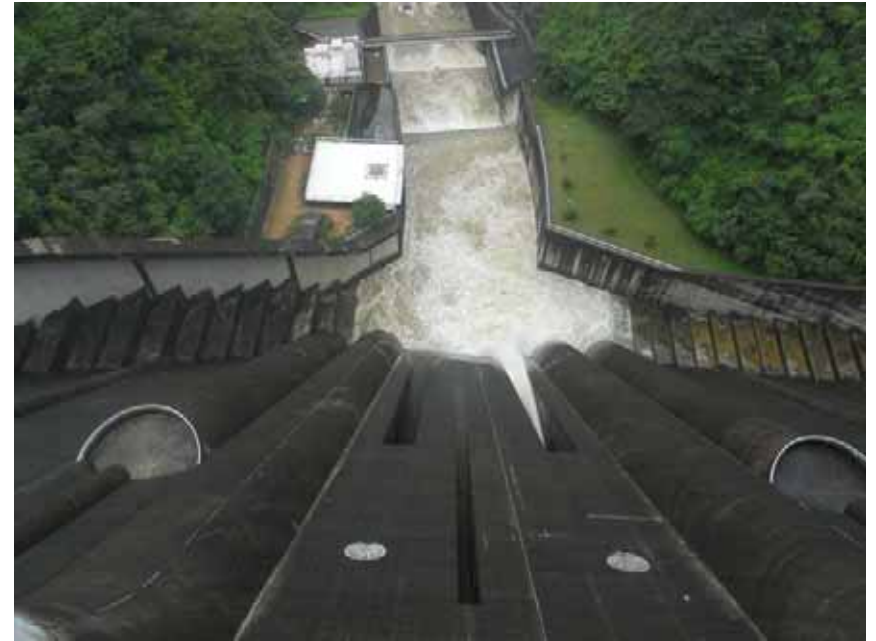
常用洪水吐からの放流状況(約17m 3 /s)
