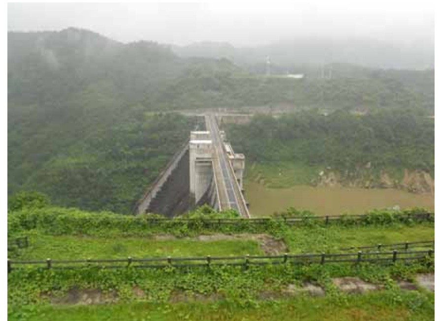
堤体・貯水池の状況
